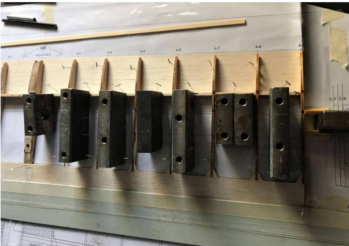
Rippen ausgerichtet und fixiert
